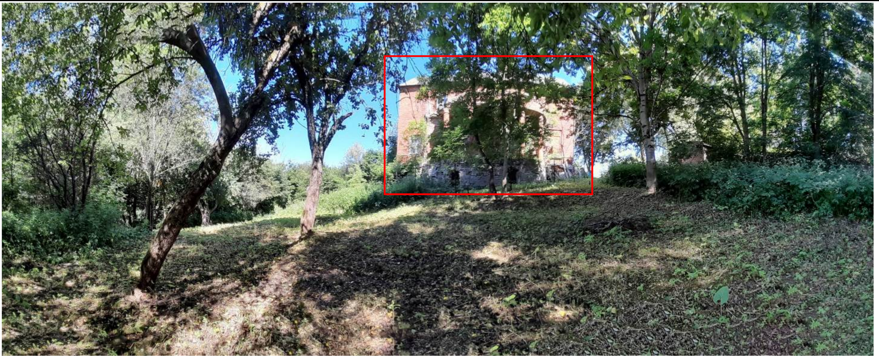
Фото 6. Развертка местности в восточном направлении. Видовая точка ближнего визуального восприятия рассматриваемого объекта культурного наследия.
