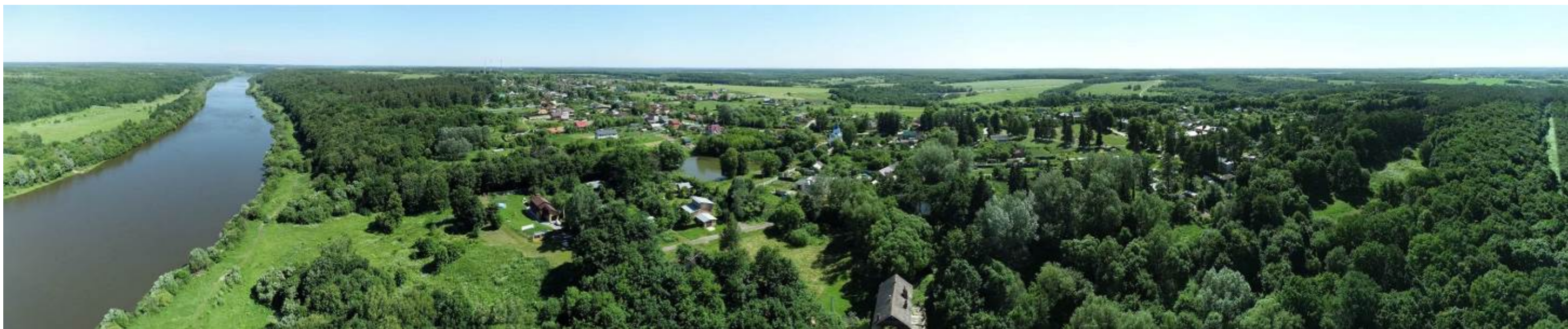
Фото 127. Аэрофотосъемка объекта культурного наследия в южном направлении.
