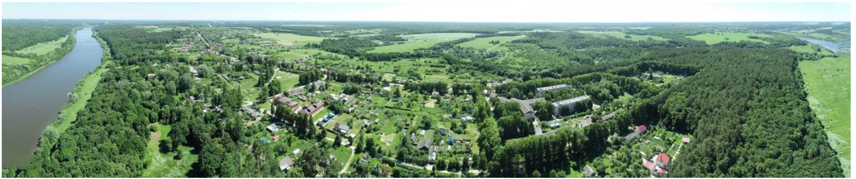
Фото 109. Аэрофотосъемка объекта культурного наследия в южном направлении.
