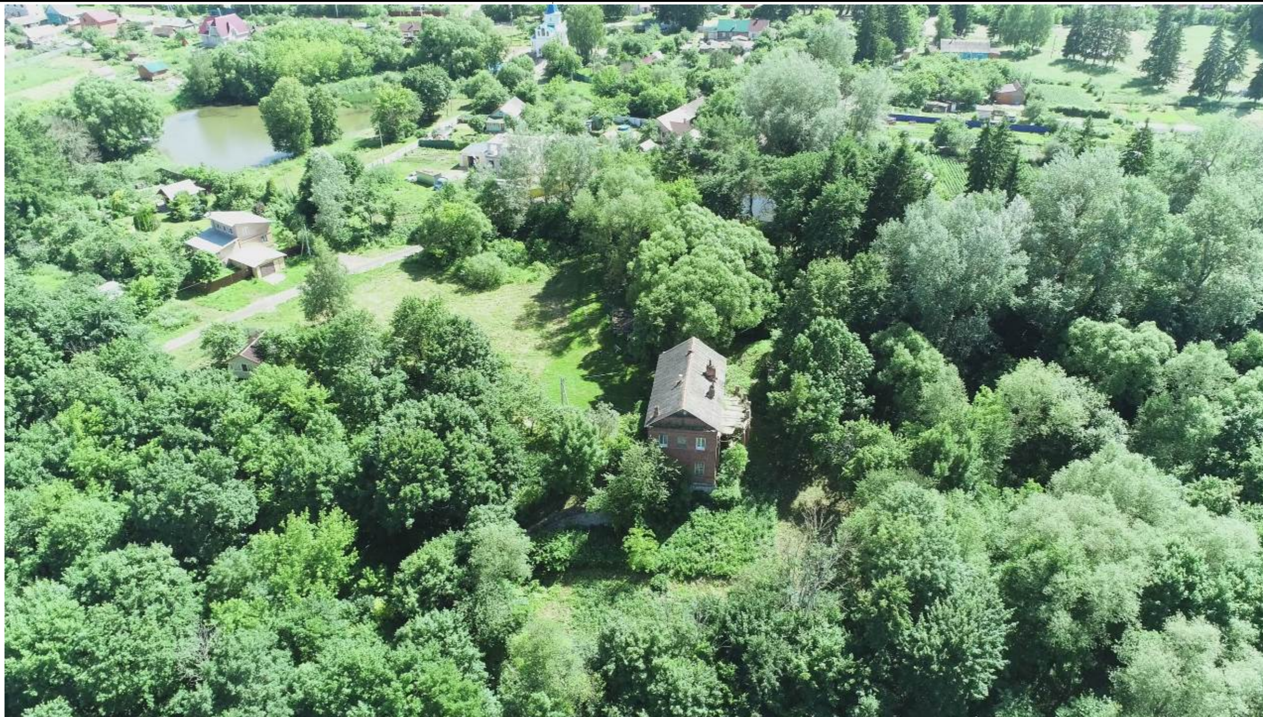
Фото 125. Аэрофотосъемка объекта культурного наследия в южном направлении.
